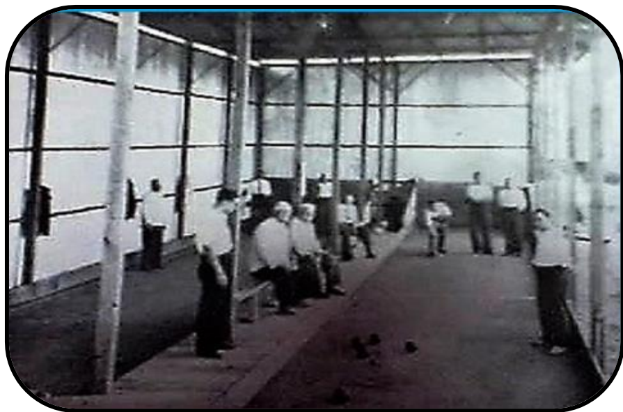
Defensa construye dos canchas de Bochas techadas
